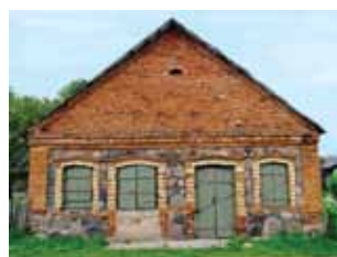
Будынак яўрэйскай лаўкі Здание еврейской лавки
