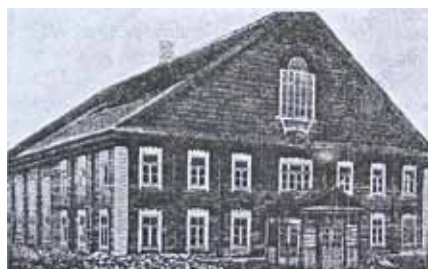
Будынак сiнагогі (не існуе) / Синагога (не существует)
